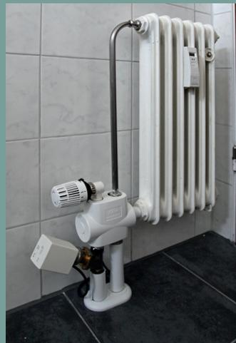
**Funk-Stellventil im Einrohring zur Regelung** der Rücklauftemperatur in Abhängigkeit der Außentemperaturgeführten Vorlauftemperatur.
