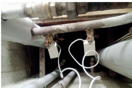
**Bild 4:** Stahlrohr-Fußbodenheizung im 90-Familien-Wohnblock in Saint Priest. Dort wurden 108 Fußbodenheizkreise mit Stellantrieben nachgerüstet.
