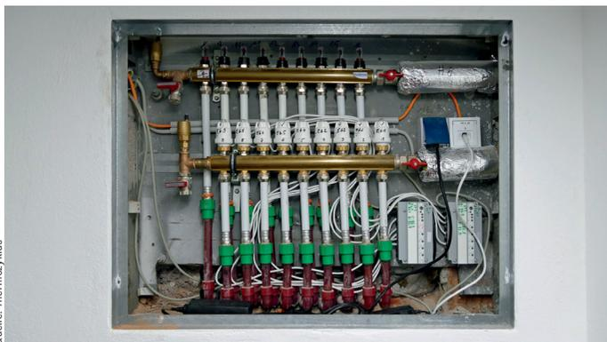
Der Eingriff in das bestehende hydraulische System war gering. Neu sind die elektrothermischen Stellantriebe mit Auf-/Zu-Funktion und die Standard-Drosselventile für den hydraulischen Abgleich.
