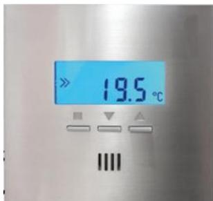
Pour pouvoir réagir immédiatement face à un incident (chute de température brutale suite à une ouverture de fenêtre ou augmentation de la température (soleil...), la sonde d'ambiance Thermozyklus ou équivalent devra mesurer la température ambiante en temps réel soit au moins 1 fois par minute.
