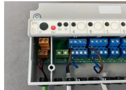
Die Stromversorgung für die Stellantriebe wird an den beiden grünen Klemmen angeschlossen, links auf der Platine mit L1 für stromführender Leiter und N für Nulleiter bezeichnet. Im Bild sind 2 Adern einer Leitung 3 x 1,5 mm<sup>2</sup> angeschlossen. Dies ist der maximale Quer-
