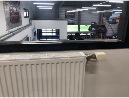
Moteur de vanne auto-équilibrant sur radiateur
