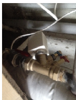
Logements de Saint Priest (69)
