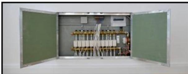
L'utilisation de moteurs de vanne économes permet leur alimentation en électricité par un câble bus de 18 Volt. Malgré la puissance de calcul élevée des unités centrales, le système Thermozyklus consomme ainsi seulement une faible quantité d'énergie.
