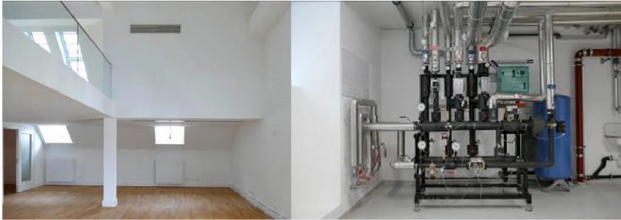
Les combles, basses de plafond, sont chauffées par des radiateurs et des plinthes chauffantes. La régulation Thermozyklus, autonome et auto adaptative, comprend rapidement les particularités thermiques d'un appartement mansardé. Le système de climatisation ambiante (sortie d'air en haut) est régulé séparément.
