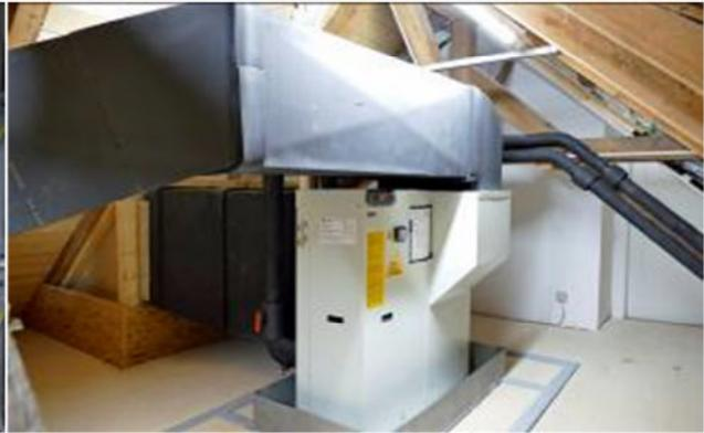
Pas de confort sous les combles sans climatisation : une climatisation à circulation d'air bien régulée soutient le système de ventilation de l'appartement.
