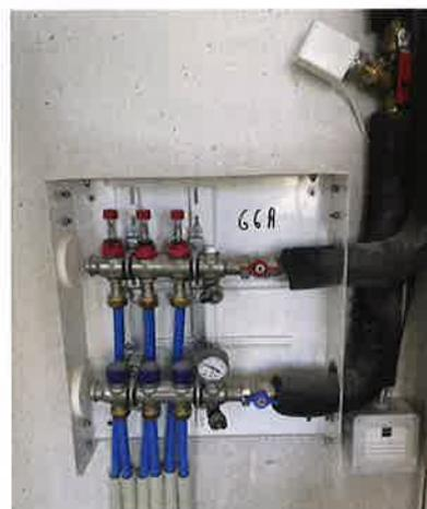
Lorsqu'une pièce comporte plusieurs boucles, le choix a été fait d'installer un seul moteur en amont sur une seule vanne qui pilote l'ensemble des boucles d'une même pièce. C'est le cas sur les planchers chauffants mais les radiateurs sont nus, connectés soit sur des vannes en faux-plafond soit sur des collecteurs comme pour les planchers.
