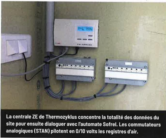
La centrale ZE de Thermozyklus concentre la totalité des données du site pour ensuite dialoguer avec l'automate Sofrel. Les commutateurs analogiques (STAN) pilotent en 0/10 volts les registres d'air.
